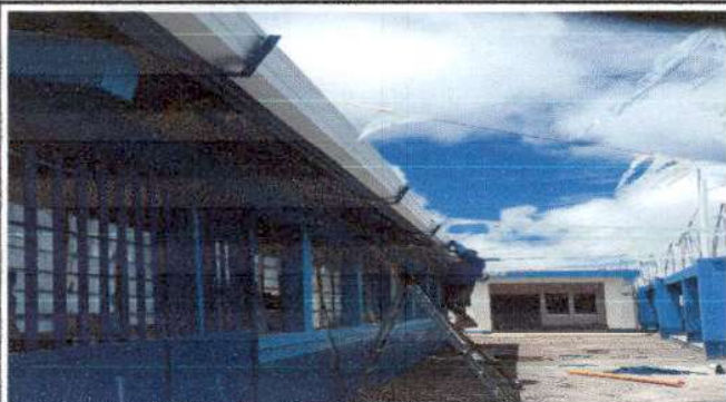
Foto 1 sustitución de canales y bajadas pluviales
