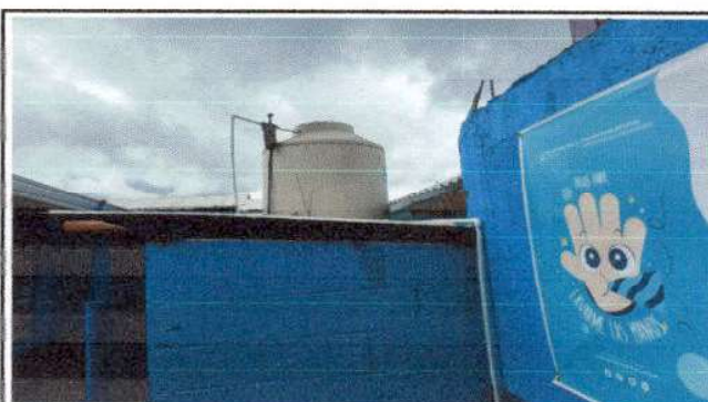
Foto 3 Sustitución de tinaco
