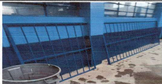
Foto 2 Sustitución de barandas metálicas
