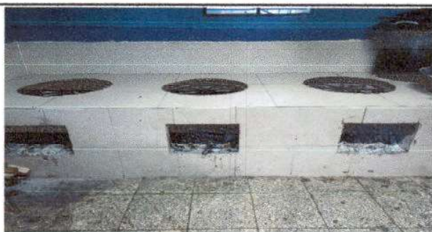
Reparacion de cocina
