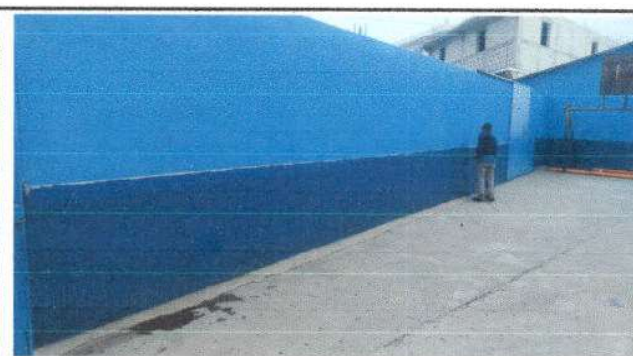
Foto 6 Pintura de muros interiores y exteriores
